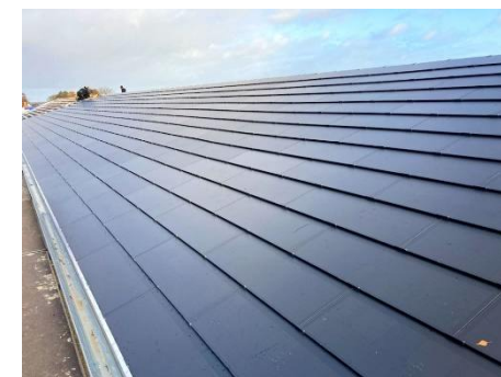
Eksempel på integrerede solceller
