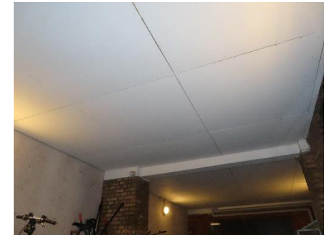
Loft i port med isolering og pladebeklædning
