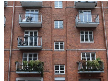
Vinduer mod gade
