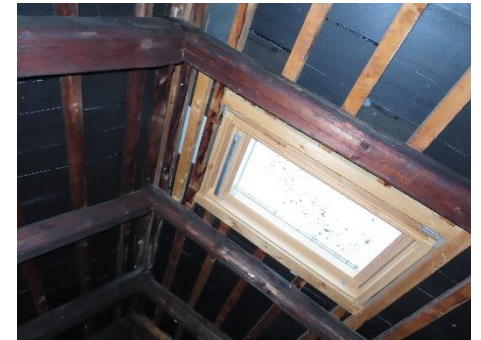
Nyere tagvindue i træ og aluminium
