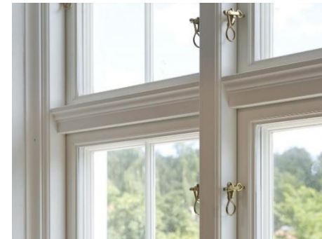
Koblet vindue set indefra
