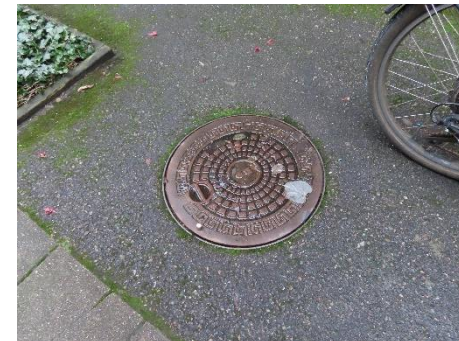
Kloakbrønd i gård
