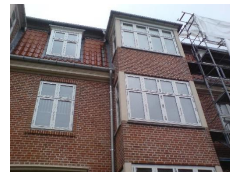
Eksempel på omfugget facade
