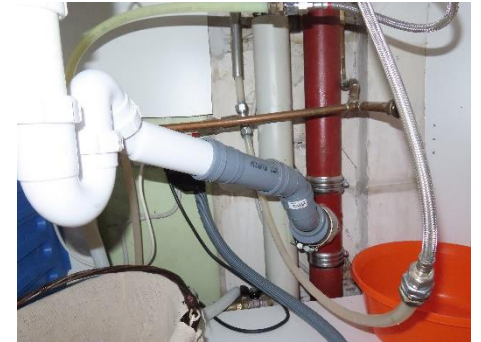
Vandinstallation i køkken
