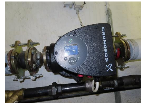
Cirkulationspumpe
