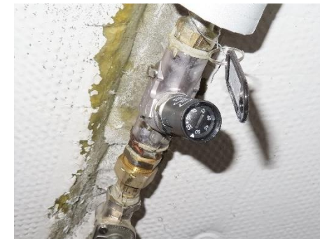
Termostatstyret cirkulationsventil
