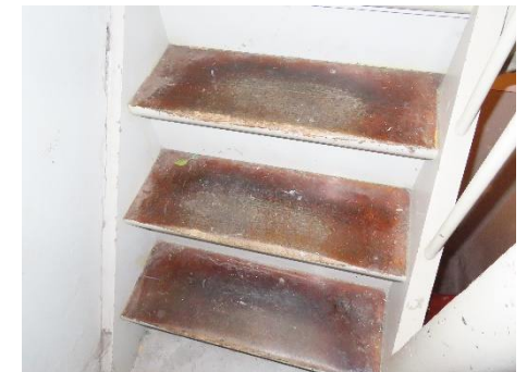
Trin på køkkentrappe
