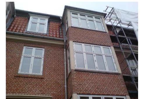
Eksempel på omfugget facade
