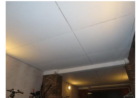
Loft i port med isolering og pladebeklædning
