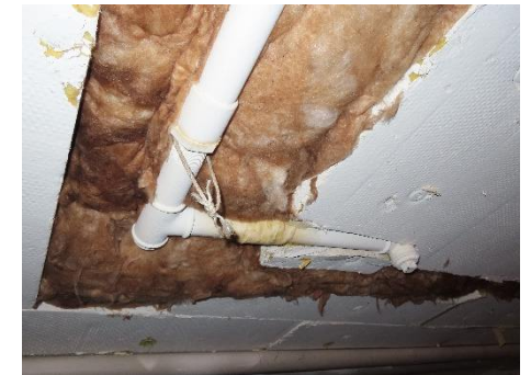
Gasrør i kælder
